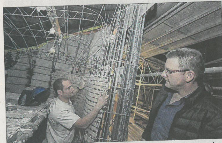
Alexandre Faure, de Wery, en train de fixer un treillis métallique cartonné sur une structure pour réaliser une transition courbe entre le nouveau bâtiment du musée et les anciens bains municipaux.
