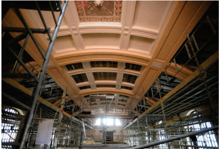
Méconnaissables, les anciens bains municipaux. La future salle événementielle sera terminée en janvier 2015. PHOTOS DNA-NICOLAS PINOT
