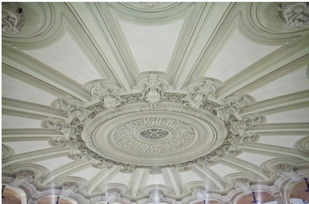
Correction acoustique du plafond de la rotonde des abonnés de l'OPERA GARNIER de PARIS. Application d'un BASWaphon avec un RAL spécifique se fondant dans la masse avec un décor classé au patrimoine.
