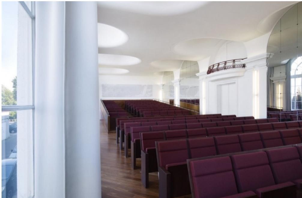
CNRS à Meudon - Salle de conférence : plafond en staff avec intégration de coques staff de forme elliptique d'environ 9m<sup>2</sup>. La surface plane est recouverte d'enduit acoustique BASWAphon
