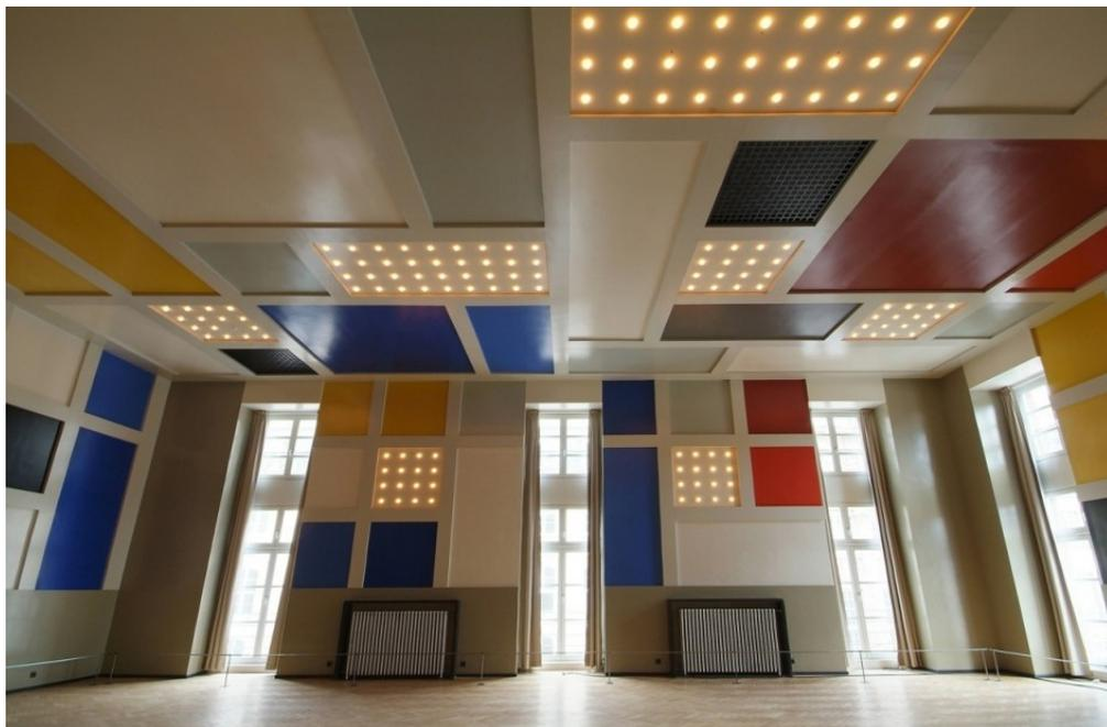
Salle des fêtes et foyer bar : restauration d'un décor sur pur et plafond époque 1920 comprenant le traînage et le moulage d'éléments de staff, plâtre traditionnel, plâtre sur treillis, plaque de plâtre.
